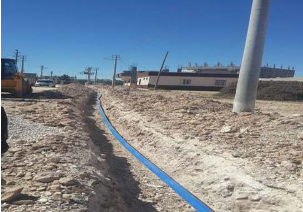
AKÇAKALE - ADNAN MENDERES MAHALLESİ İÇME SUYU HATTI DÖŞEME ÇALIŞMASI
