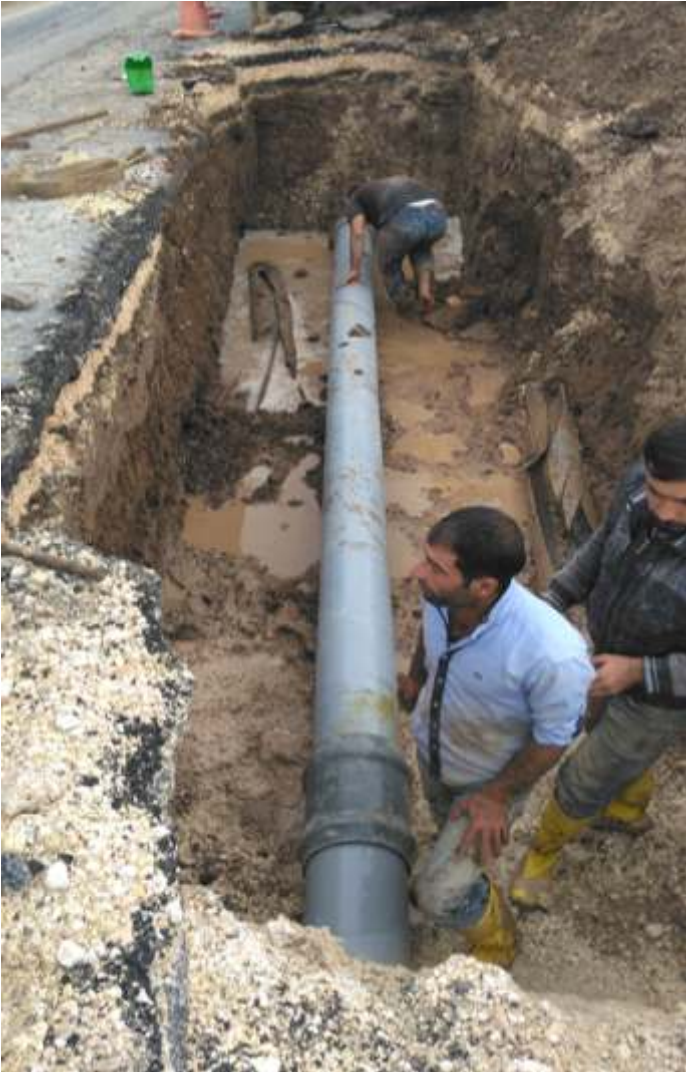
KARAKÖPRÜ - BALIK AYAĞI BULVARI 4278. SOKAK 280 MM PVC BORU ONARIMI
