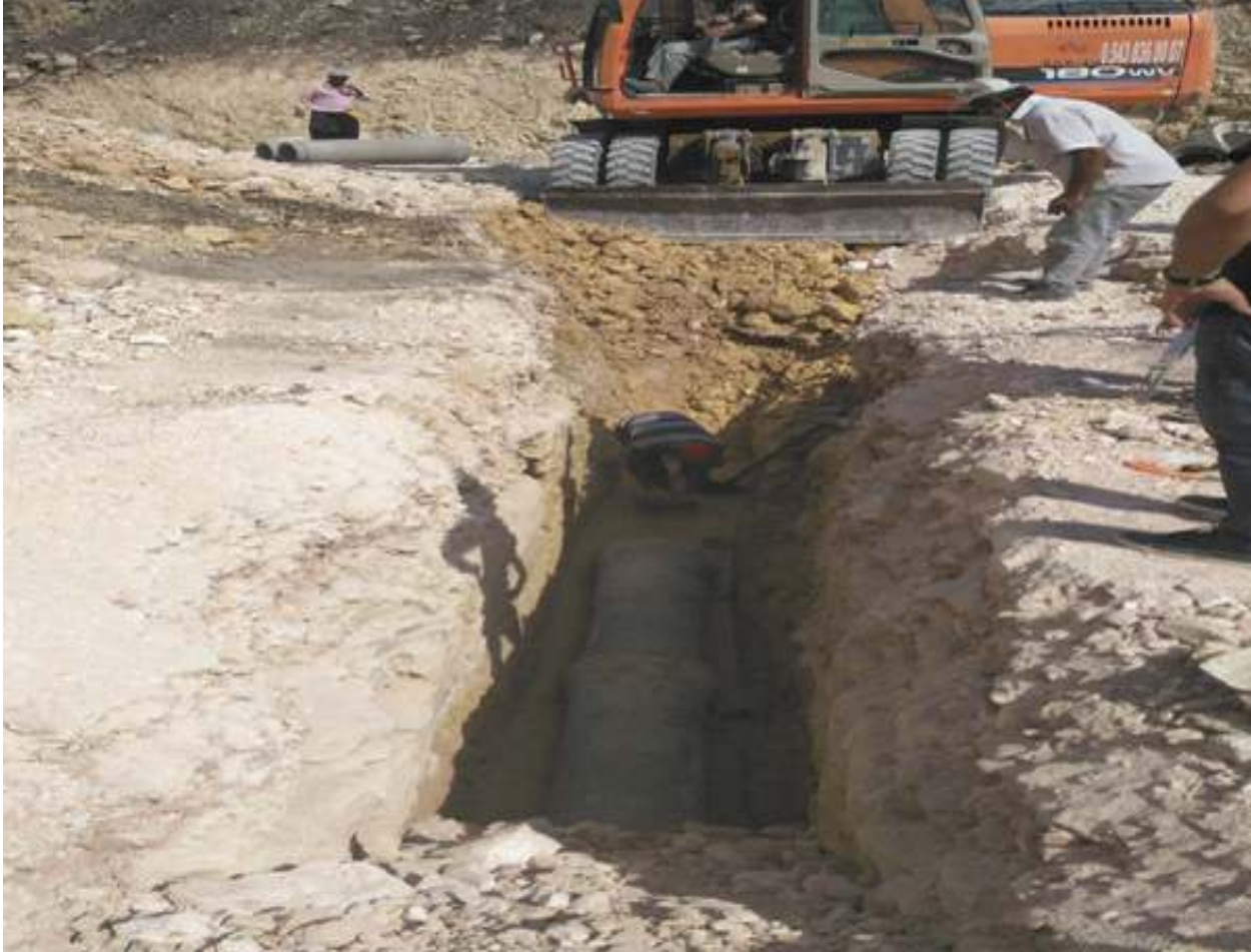
KARAKÖPRÜ - KANAL ÇALIŞMASI
