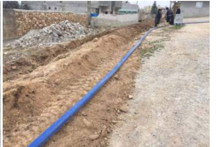
BOZOVA - FEVZİ ÇAKMAK MAHALLESİ İÇME SUYU ŞEBEKE DÖŞEME
