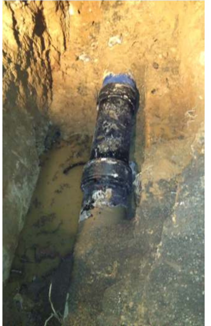
HALİLİYE - ŞEHİTLİK MAHALLESİ 450 MM HDPE BORU ONARIMI
