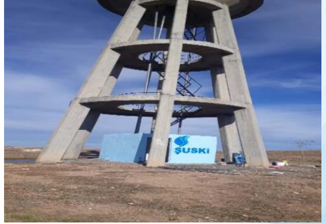
SURUÇ KÜÇÜK OVA (YENİ HALİ)
