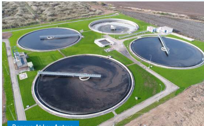
Bozova Atıksu Arıtma
