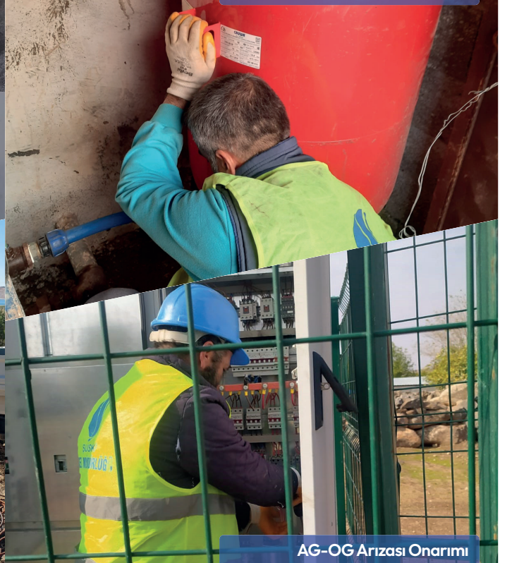
Hidrofor Arızası Onarımı
